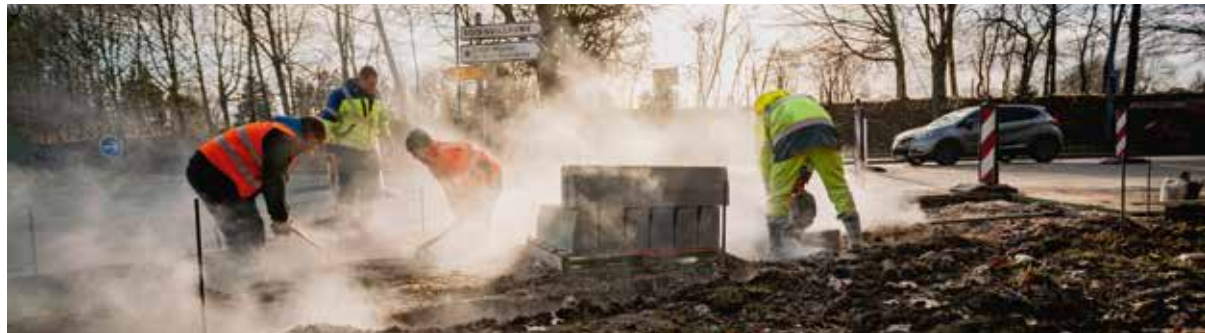
> La Métropole va aménager des dizaines de kilomètres de pistes cyclables chaque année, comme ici route de Darnétal à Bois-Guillaume.
