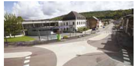
À Malaunay, une entrée de ville réaménagée et sécurisée.
