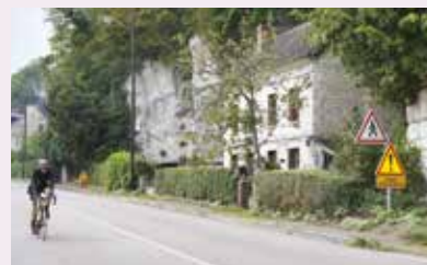
📍 À Duclair et Saint-Pierre-de-Varengeville , sécuriser les voiries à proximité des falaises.
