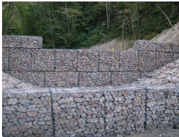
Seuil dans le talweg en aval de la digue
