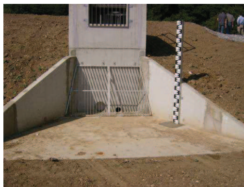
Ouvrage de fuite de la digue aval
