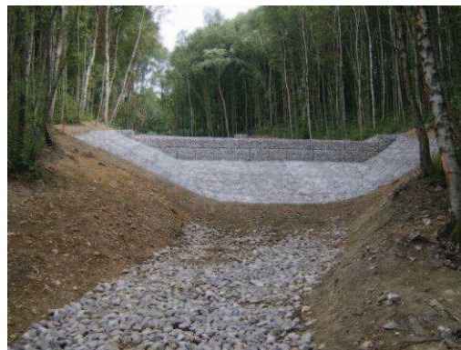
Aménagement de l'arrivée d'eau dans le bois en matelas anti-érosifs
