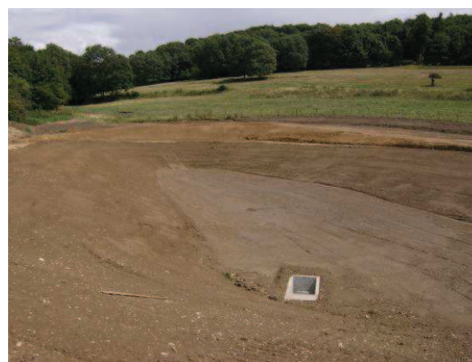
Terrassement des ouvrages de régulation du Grand Val à Amfreville la Mivoie – Août 2009
