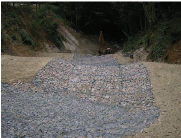
Aménagement de la surverse de la digue confortée
