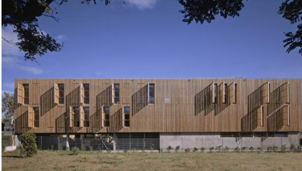
Bureaux de la Régie de l'Eau, Mathieu&Radisson / Atelier 5, Six-Fours
