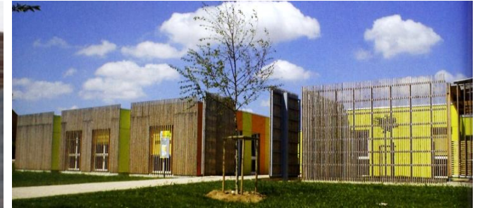
Filtre bois en façade, Centre de soins, scpa perche-Bougault
