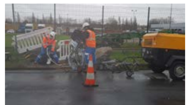
Chantier rue de l'industrie au Grand-Quevilly
