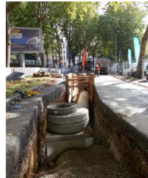
Chantier Boulevard de Verdun à Rouen
