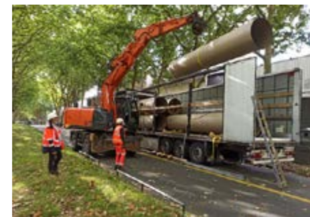
Chantier Boulevard de Verdun à Rouen
