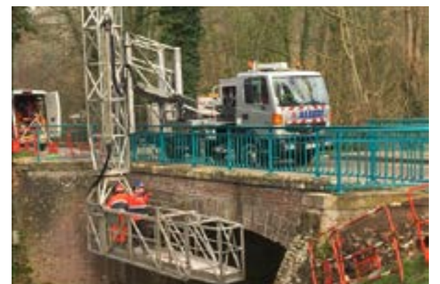
Passage en encorbellement au-dessus de l'Austreberthe
