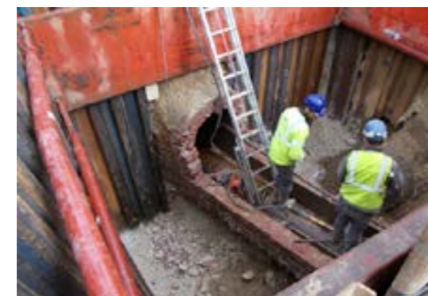
Chantier Boulevard de Verdun à Rouen
