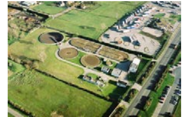
Station d'épuration de Grand Quevilly
