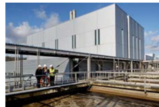
Station d'épuration Émeraude
