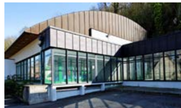
Usine d'eau potable à Moulineaux
