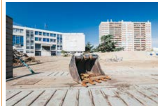
Requalification complète de la place de l'hôtel-de-ville de Sotteville-lès-Rouen
