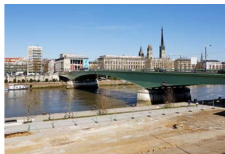
Site de l'ex hangar 105 à Rouen
