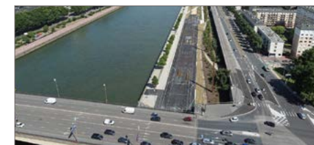
Quais bas rive gauche aménagés
