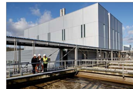
Station d'épuration Émeraude à Petit-Quevilly
