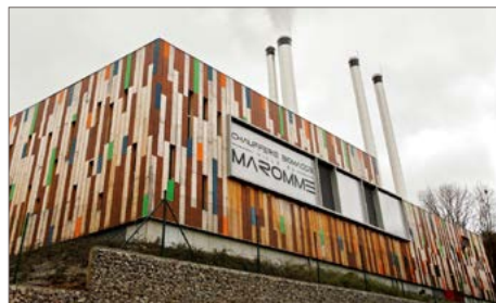
Chaufferie biomasse de Maromme
