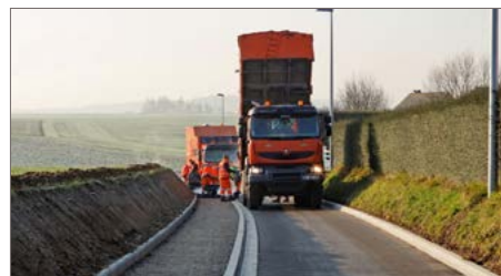
Travaux de voirie à Gouy
