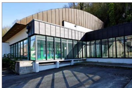
Station d'eau potable de Moulineaux
