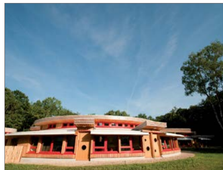
Maison de la forêt à Darnétal
