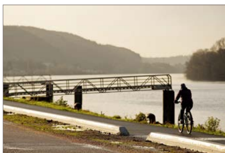
Nouvelle piste cyclable Seine Amont rive droite Belbeuf – Rouen
