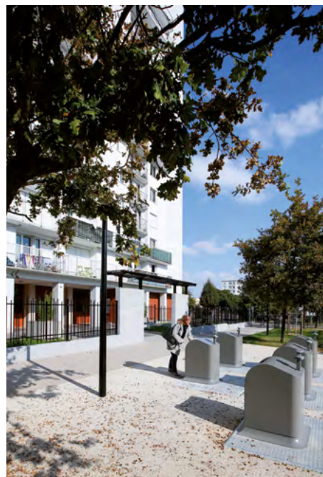
Colonnes enterrées pour l'apport volontaire des déchets ménagers, papiers et emballages
