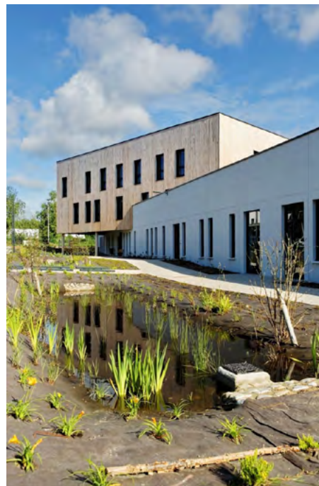
Seine-Ecopolis à Saint-Étienne-du-Rouvray
