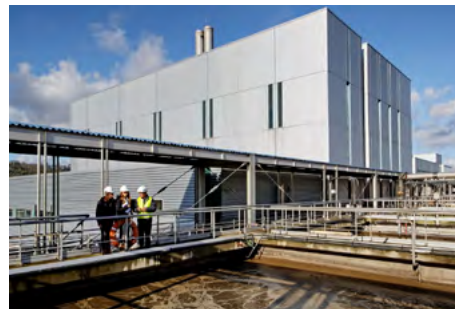
Station d'épuration Émeraude à Petit-Quevilly
