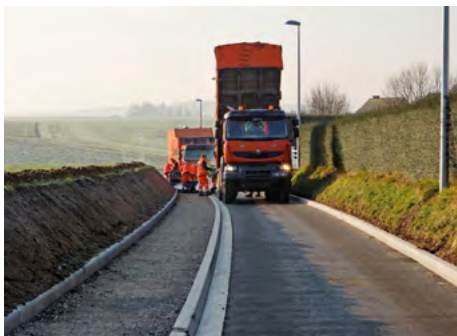
Travaux de voirie à Gouy
