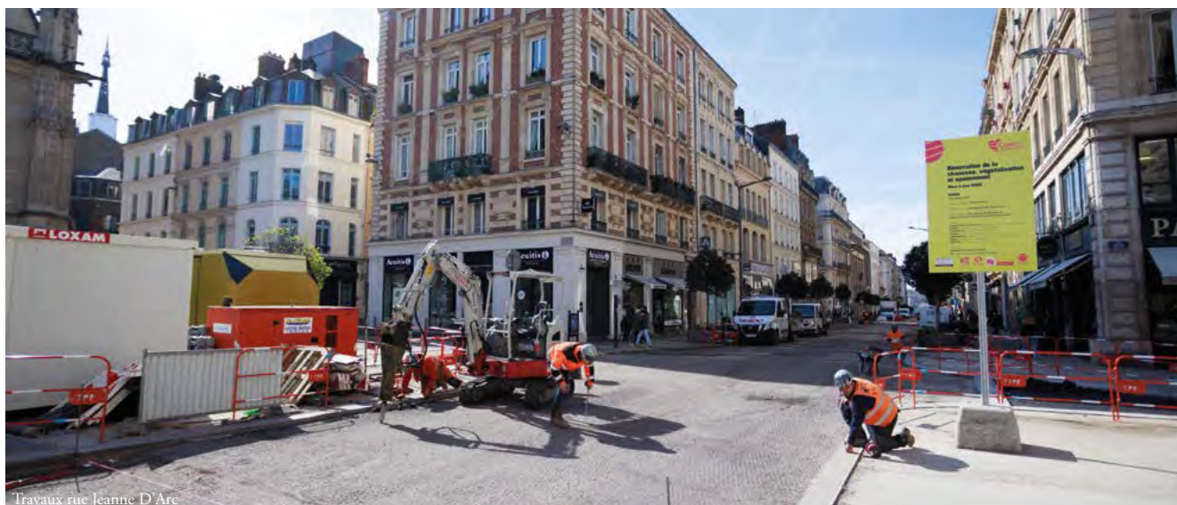
Travaux rue Jeanne D'Arc
