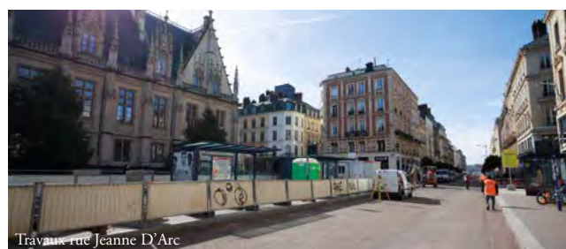
Travaux rue Jeanne D'Arc
