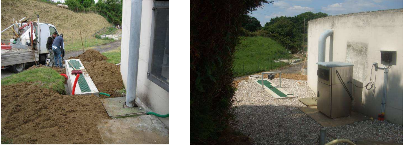
Figure 1 : Mise en place des équipements d'autosurveillance : Canal de comptage venturi et deux préleveurs réfrigérés fixes.
