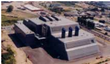
Unité de valorisation énergétique du SMEDAR
