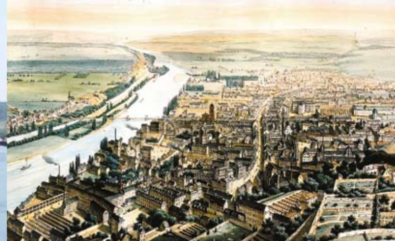
Vue générale d'Elbeuf par Asselineau, dans « Voyages aériens », 1850. © Archives d'Elbeuf. Les premiers ponts reliant les deux rives de la Seine, Elbeuf et Saint-Aubin-lès-Elbeuf, sont construits en 1843 ; de nombreuses îles occupent encore le lit principal du fleuve.
