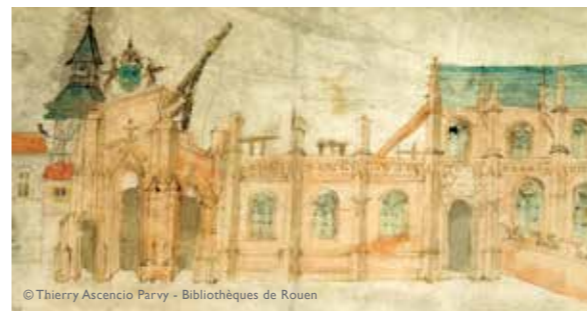
Le chantier de l'abbatiale en 1525 tiré du Livre des Fontaines de Jacques Le Lieur
