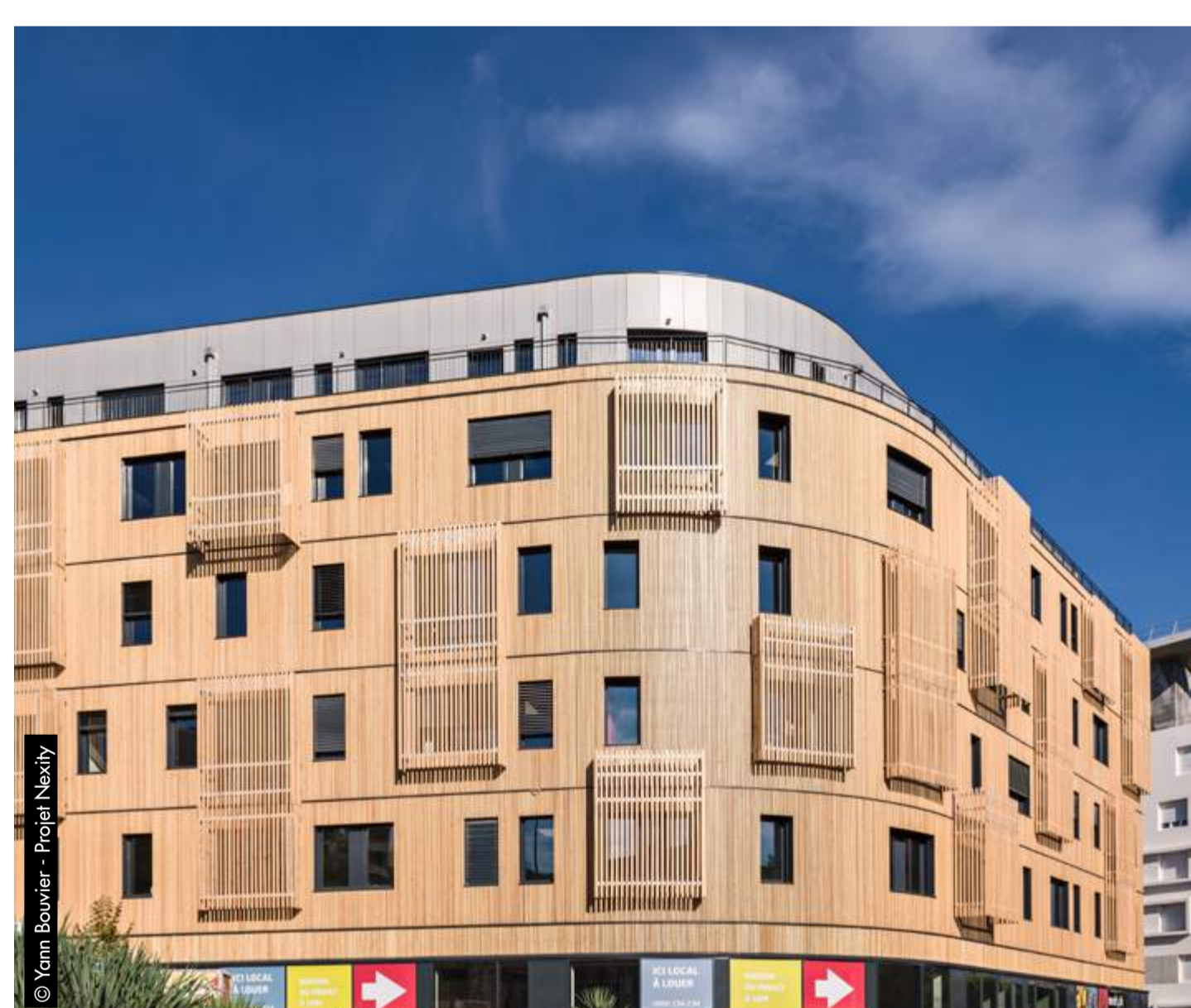
Le bois dans les constructions à Marseille Les bois utilisés peuvent être apparents ou pas en fonction des essences régionales.
