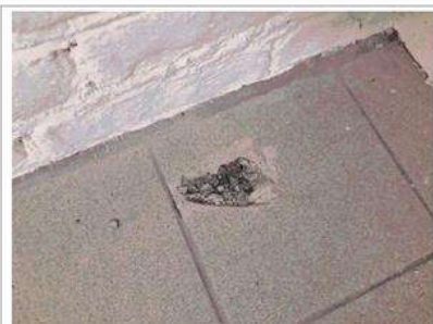
Prélèvement - P002 : Rez-de-chaussée / Pièce 2 - Colle de carrelage- (Absence d'amiante)
