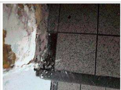
Prélèvement - P005 : Rez-de-chaussée / Pièce 1 - Colle de carrelage- (Absence d'amiante)
