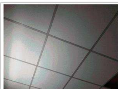
Déclaré - : Rez-de-chaussée / Pièce 1 - Faux plafond- (Absence d'amiante)
