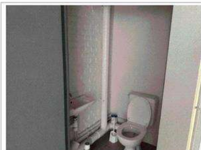
Déclaré - : Rez-de-chaussée / WC - Conduit- (Absence d'amiante)
