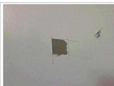
Prélèvement - P012 : Rez-de-chaussée / Pièce 2 - Peinture- (Absence d'amiante)
