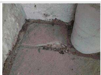
Prélèvement - P003 : Rez-de-chaussée / Pièce 1 - Colle de carrelage- (Absence d'amiante)
