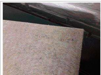
Déclaré - : Rez-de-chaussée / Pièce 1 - Faux plafond- (Absence d'amiante)
