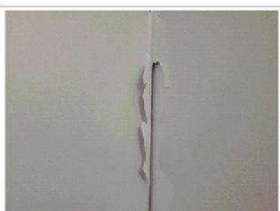
Prélèvement - P011 : Rez-de-chaussée / Cuisine - Peinture- (Absence d'amiante)
