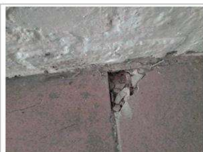
Prélèvement - P004 : Rez-de-chaussée / Pièce 1 - Colle de carrelage- (Absence d'amiante)
