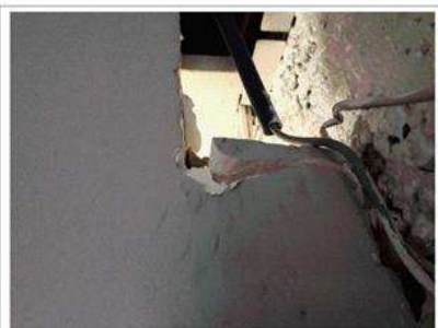
Prélèvement - P015 : Rez-de-chaussée / Pièce 1 - Plaque- (Absence d'amiante)
