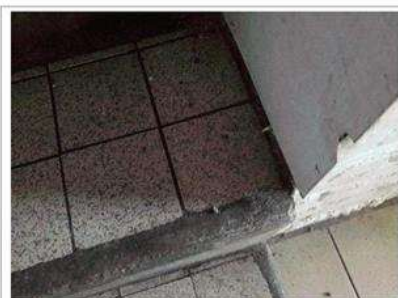
Prélèvement - P006 : Rez-de-chaussée / Pièce 1 - Colle de carrelage- (Absence d'amiante)
