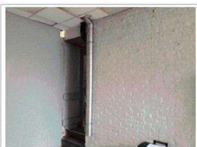
Déclaré - : Rez-de-chaussée / Pièce 1 - Conduit- (Absence d'amiante)
