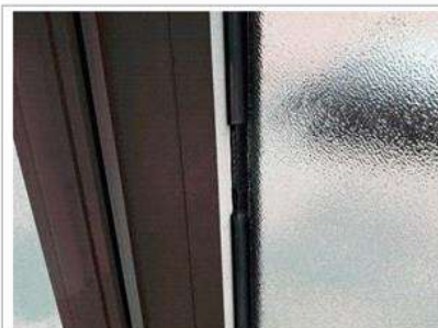
Prélèvement - P020 : Rez-de-chaussée / Pièce 1 - Joint- (Absence d'amiante)
