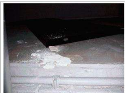
Prélèvement - P019 : Rez-de-chaussée / WC - Plaque- (Absence d'amiante)
