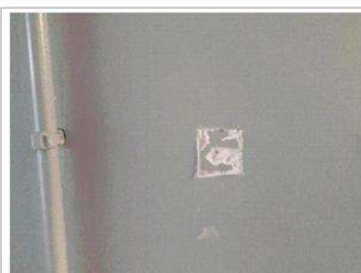
Prélèvement - P010 : Rez-de-chaussée / Pièce 1 - Peinture- (Absence d'amiante)
