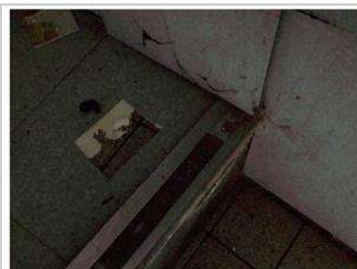
Prélèvement - P008 : Rez-de-chaussée / Pièce 1 - Nez de marche- (Absence d'amiante)
