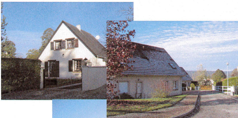
Des pavillons plus récents
