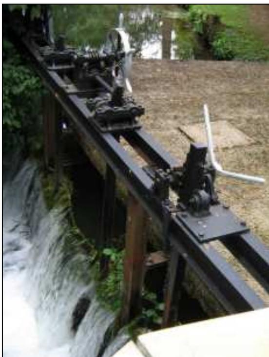
**Photo 6 : vannage sur le canal de décharge**
