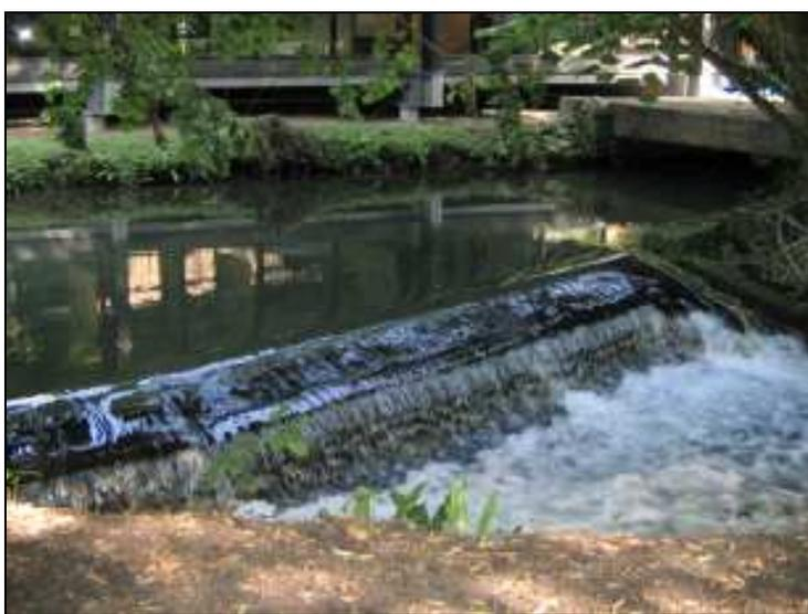
**Photo 7 : déversoir sur le canal de décharge**
