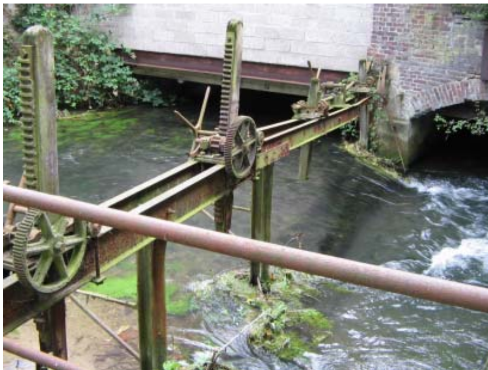
vestiges du vannage
