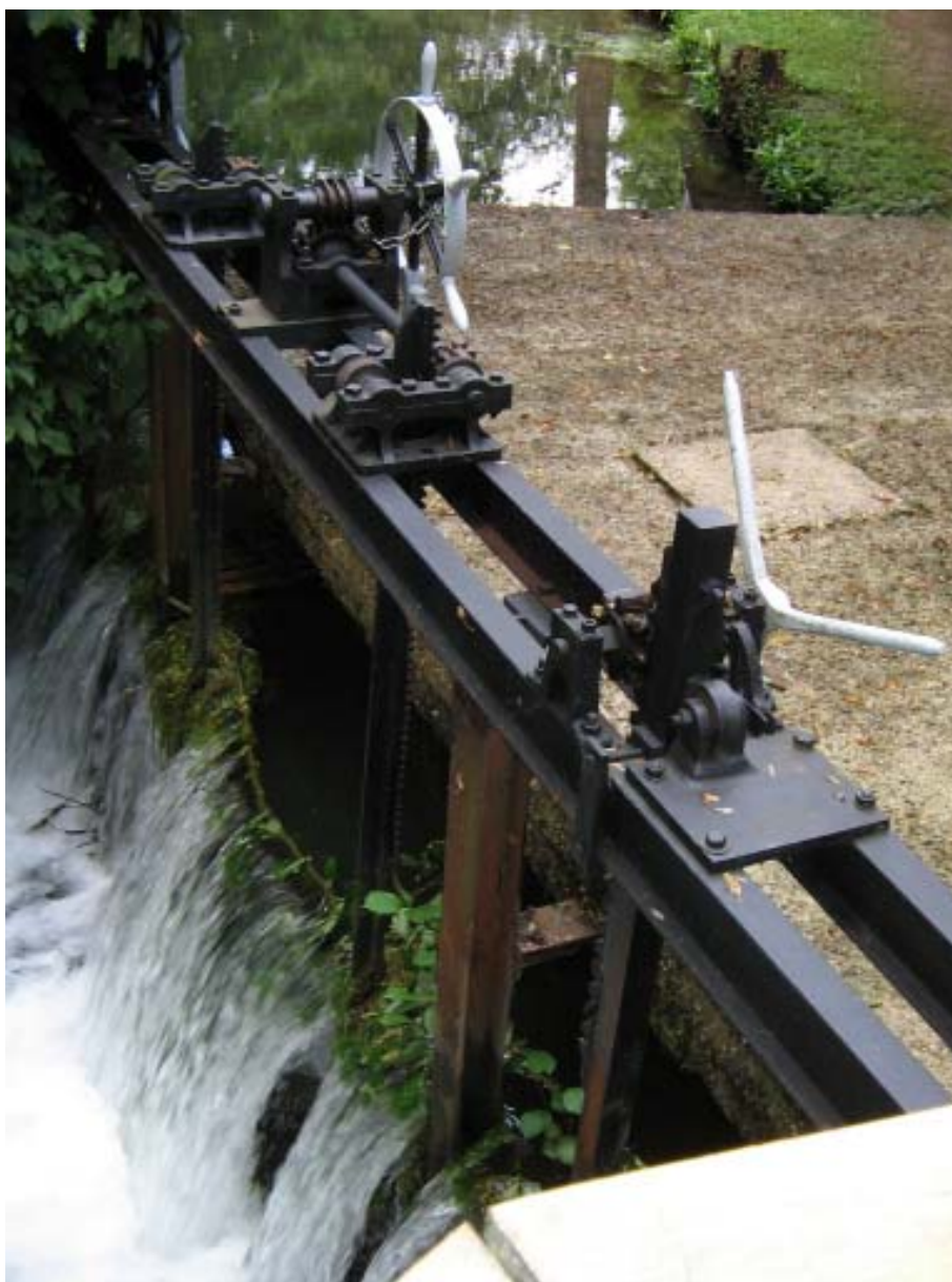
vannes levantes vues depuis l'aval
