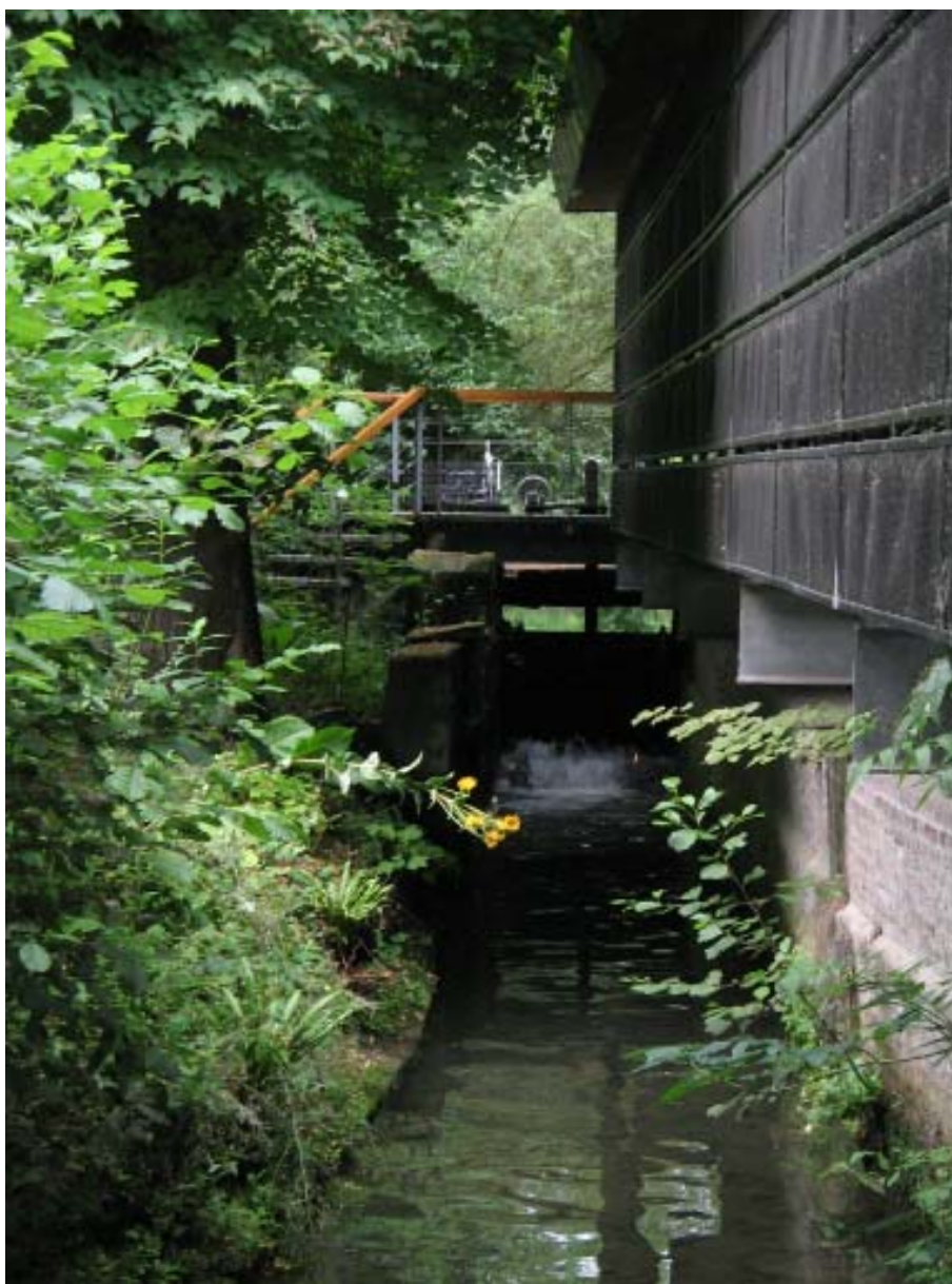
Vue aval de la vanne levante
