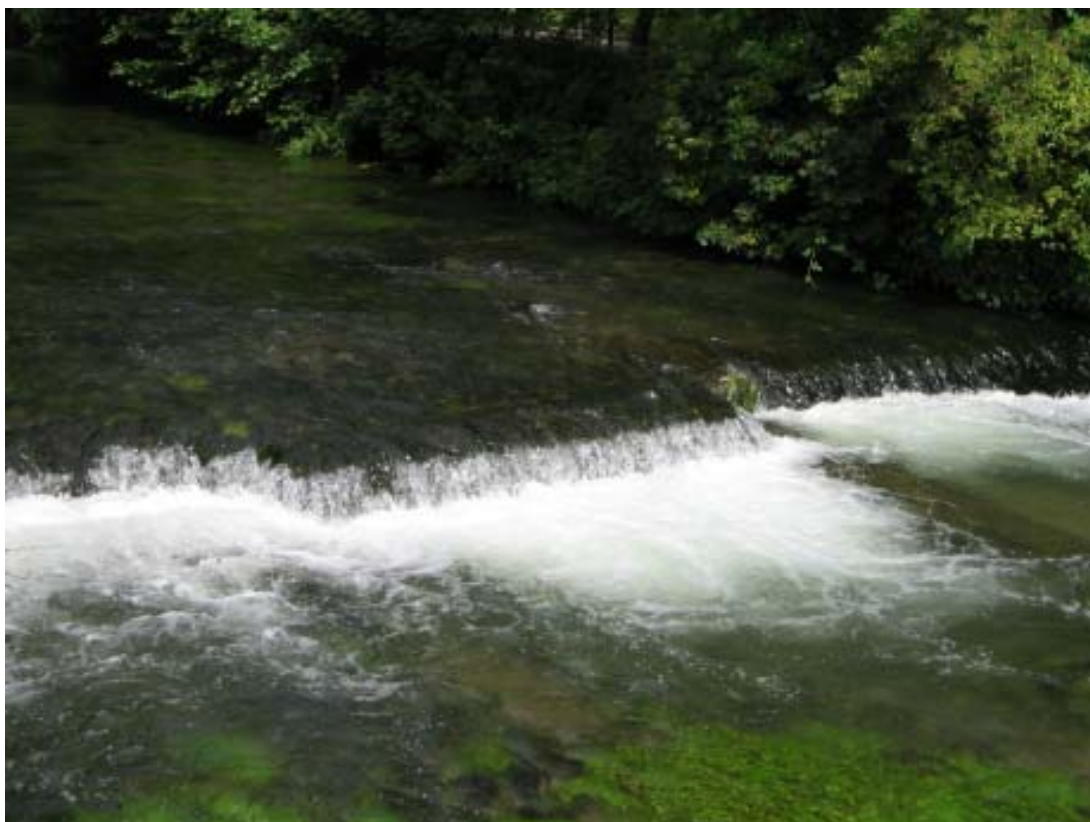
vue aval de l'ouvrage
