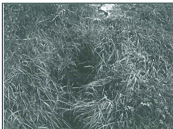
Canalisation en partie obstruée
