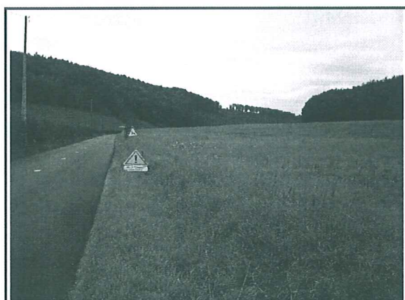
Fossé drainant les eaux de voirie
