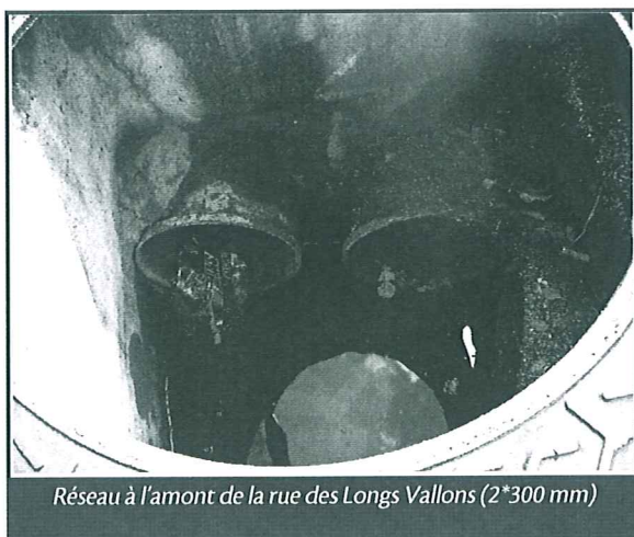
Photo 14(vues a et b) : Eléments hydrauliques du sous bassin n°27
