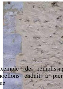
Exemple de remplissage moellons enduit à pierre vue
