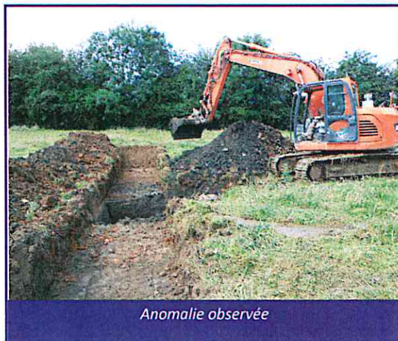
Photo 4 (vues a et b) : Sondage réalisé au droit de l'indice de cavité n°126
