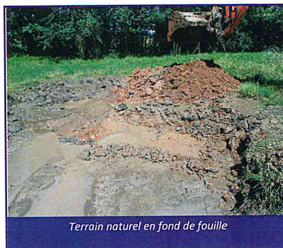
Photo 6 (vues a et b) : Sondage réalisé au droit de l'indice de cavité n°128
