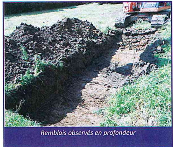
Photo 9 (vues a et b) : Sondage réalisé au droit du nouvel indice de cavité
