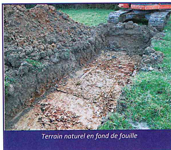
Photo 6 (vues a et b) : Sondage réalisé au droit de l'indice de cavité n°128
