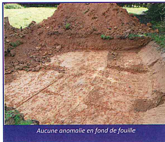
Photo 3 (vues a et b) : Sondage réalisé au droit de l'indice de cavité n°125
