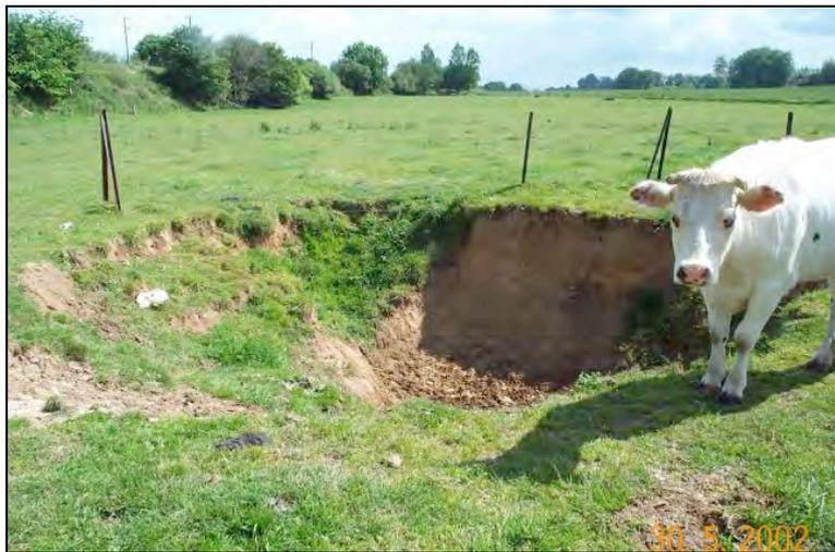
Figure 11 : Effondrement localisé, diamètre environ 10m, profondeur environ 3m, commune de Bolleville (76) [LRPC de Rouen, 2002]
