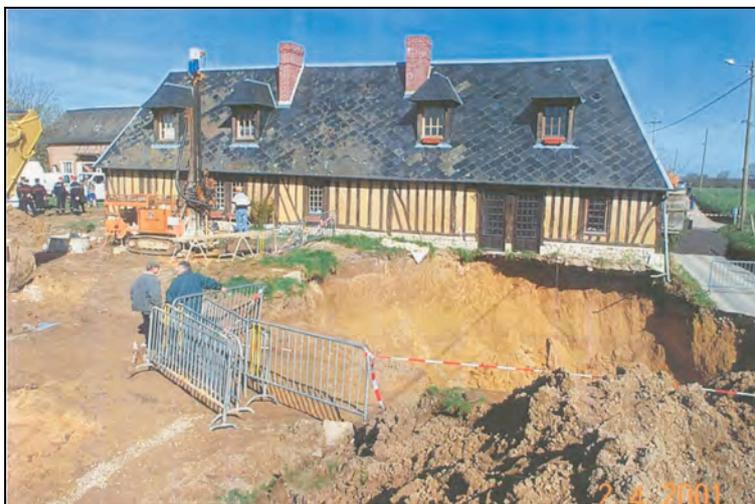
*Figure 17 : Effondrement spontané en liaison avec l'effondrement partiel d'une marnière souterraine, diamètre 15m, profondeur environ 10m, commune de Neuville-sur-Authou (27) [LRPC de Rouen, 2001]*
