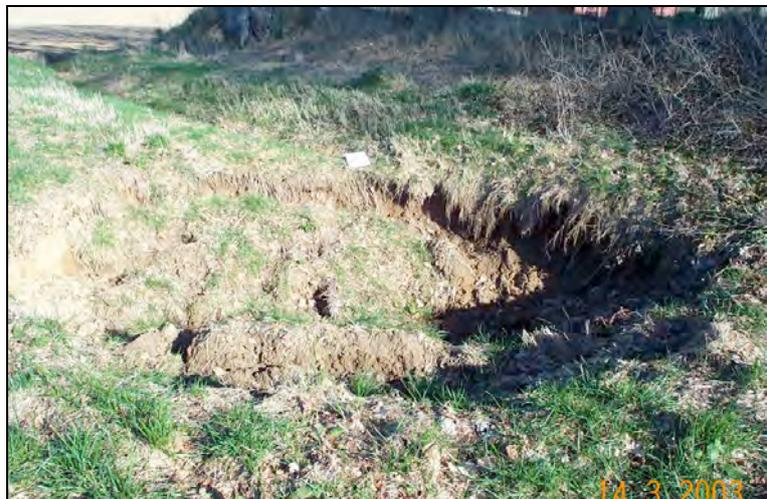
**Figure 10 : Fontis en liaison avec une cavité souterraine, diamètre 4m, profondeur 0.50m, commune d'Etainhus (76)[LRPC de Rouen, 2003]**
