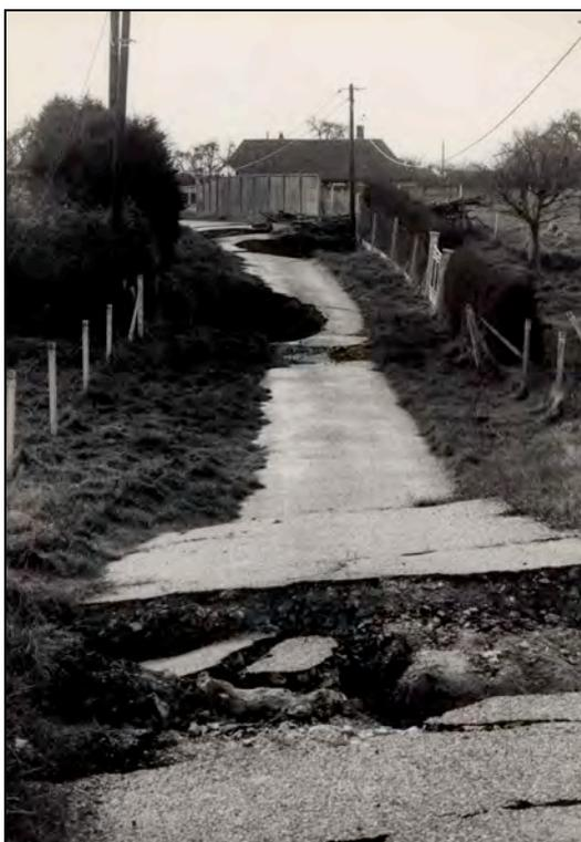
*Figure 18 : Effondrement spontané en liaison avec l'effondrement quasi-total d'une marnière souterraine, diamètre environ 50m, profondeur environ 2.50m, commune de Vitot (27) [LRPC de Rouen, 1982]*
