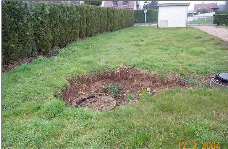
Figure 12 : Effondrement, diamètre 2m, profondeur 0.80m, se développant autour d'un regard d'assainissement, commune de Gouy (76) [LRPC de Rouen, 2004]
