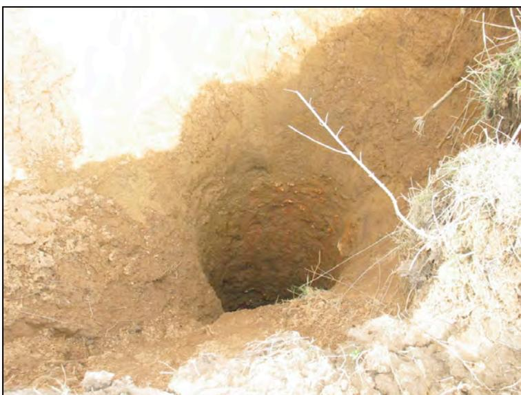
Figure 16 : Effondrement en liaison avec la vidange des matériaux de remblai d'un puits dans les galeries souterraines, diamètre 1.50m, profondeur plusieurs dizaines de mètres, commune d'Hattenville (76) [LRPC de Rouen]
