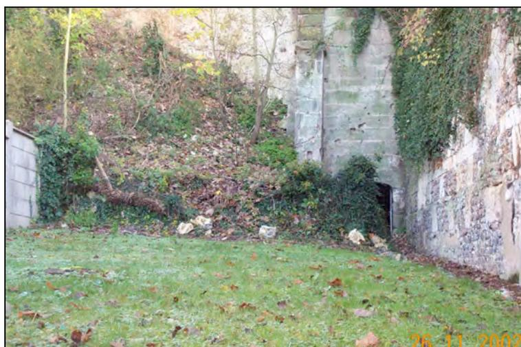
Figure 21 : Écroulement localisé de la falaise à l'aplomb de l'entrée d'une ancienne carrière souterraine, une 2<sup>ème</sup> entrée est visible à droite, commune de Beaumont-le-Roger (27) [LRPC de Rouen, 2002]
