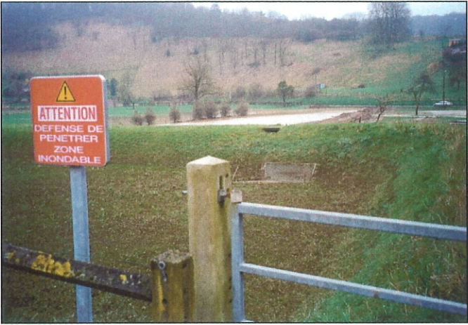
Photo 14 Bassin de régulation du Val d'Isneauville, plein + vue de la « Grande Vallée » inondée (parcelle cadastrale n° 55).
