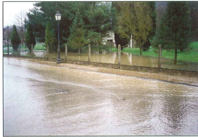
Photo 52 Inondation de la RD 61, à la hauteur de la parcelle n° 3 (vue depuis l'amont vers l'aval).
