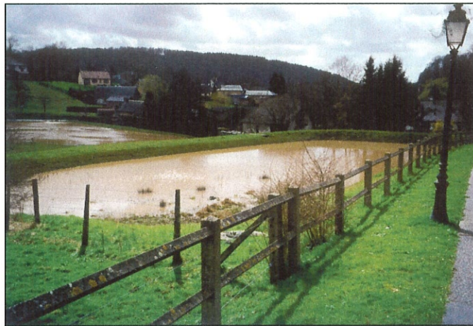
Photo 17 Bassin du Val d'Isneauville plein.
