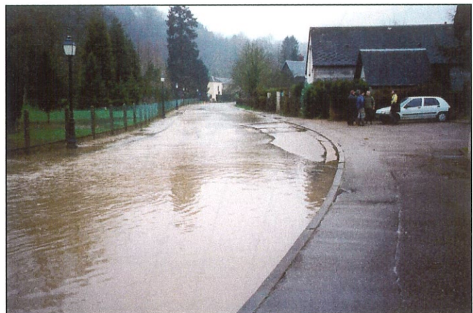
Photo 55 Inondation de la RD 61 à hauteur de la parcelle n° 3 (vue depuis l'aval vers l'amont).
