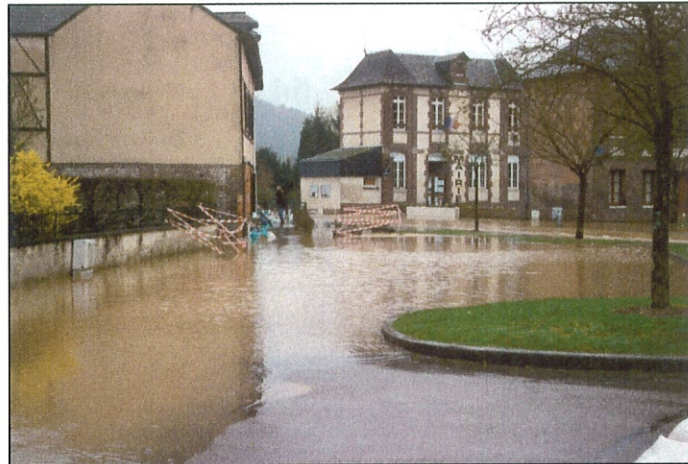
Photo 61 Parking du centre bourg + Place de la République inondés.
