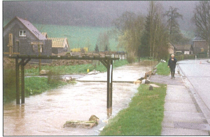
Photo 80 Niveau élevé du Robec (l'eau atteint le niveau du point d'accès à la voirie interne du lotissement).
