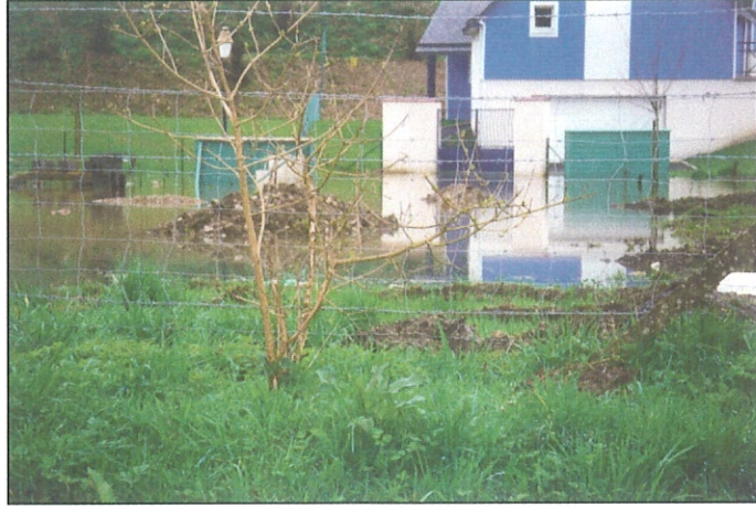
Photo 79 Terrains du lotissement en construction en partie inondés.
