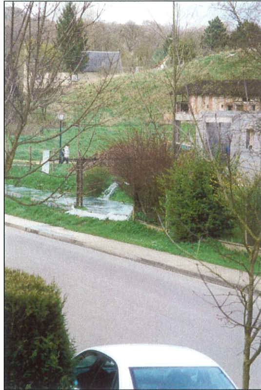
Photo 83 Pompage dans le lotissement en construction.
