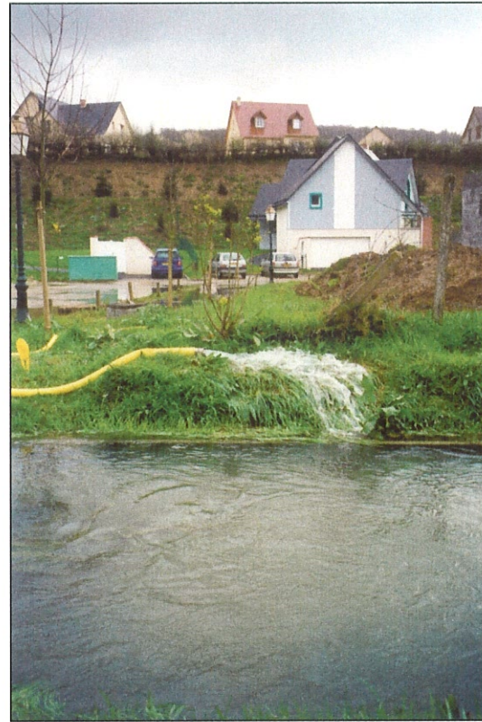
Photo 84 Pompage dans le lotissement en construction.
