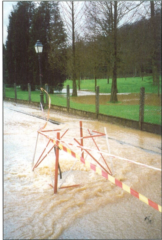
Photo 47 Débordement du réseau EP au niveau de la RD 61.
