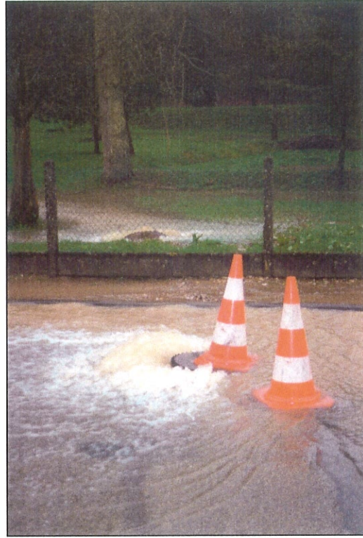
Photo 48 Inondation de la place de la Fontaine et du carrefour avec la RD 61.
