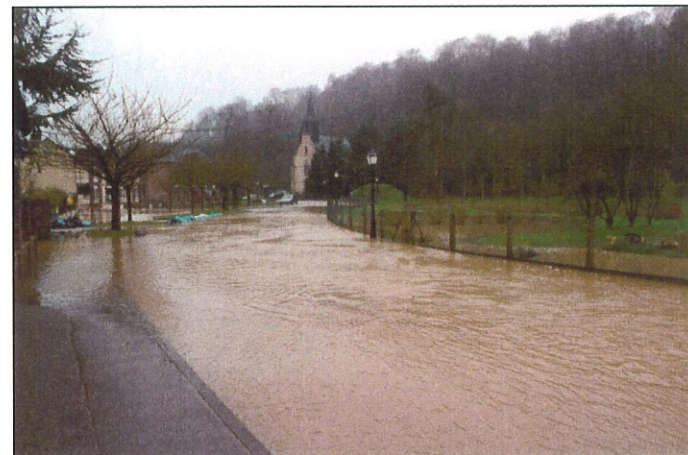
Photo 56 Inondation de la RD 61 et du parking près du centre bourg (vue depuis l'amont vers l'aval).
