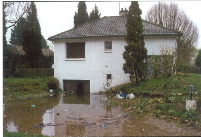
Photo 39 Sous-sol de l'habitation situé sur la parcelle n° 17 inondé (1 m d'eau environ).
