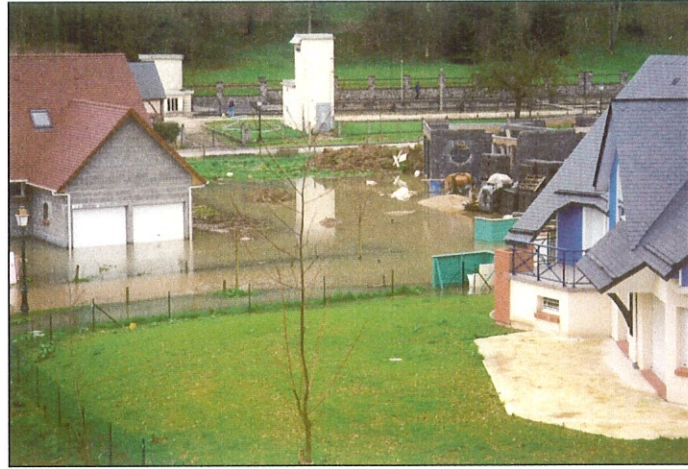
Photo 73 Garages situés sur la parcelle n° 70 + voirie interne du lotissement inondés (60 cm d'eau environ).
