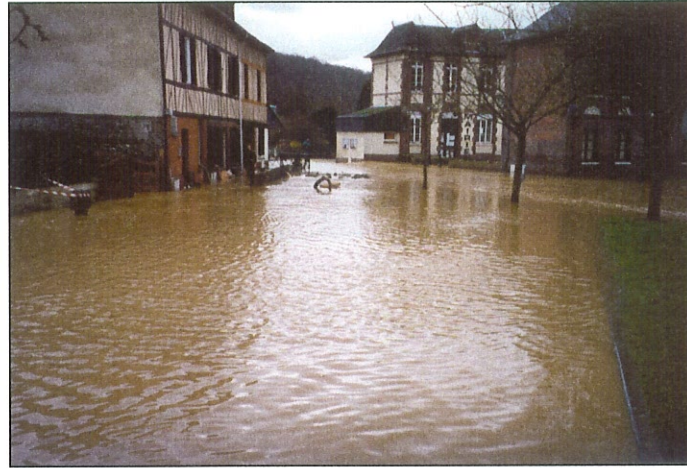
Photo 60 Parking du centre bourg + Place de la République inondés.
