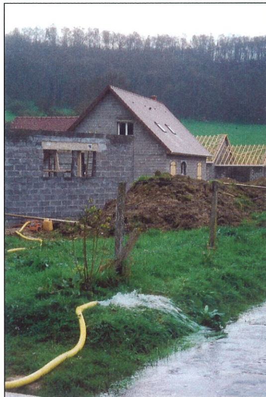
Photo 85 Pompage dans le lotissement en construction.
