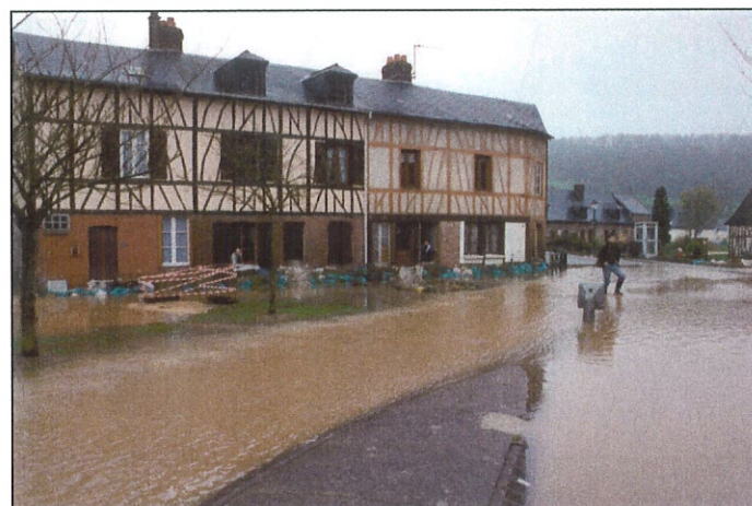
Photo 63 Parking du centre bourg + carrefour avec la route de Roncherolles inondés.
