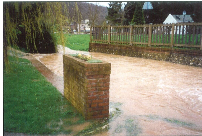
Photo 72 Niveau élevé du Robec, juste derrière la Mairie (vue vers l'aval).
