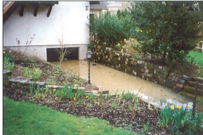
Photo 26 Sous-sol de l'habitation située sur la parcelle n° 37, inondé par 1,50 m d'eau environ.
