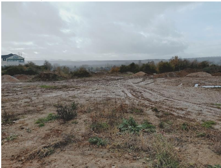
Figure 24 : Terrassement présent sur la partie Sud du site - GAMA Environnement
