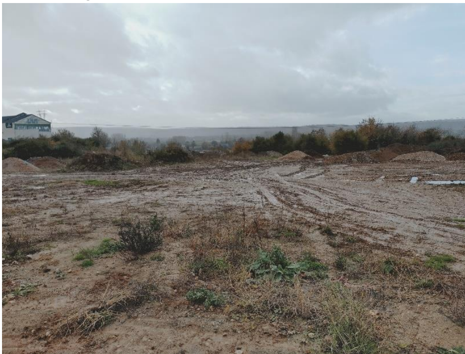
Figure 10 : Terrassement présent sur la partie Sud du site - GAMA Environnement
