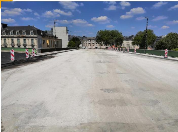
Le tablier du pont reprofilé avant les travaux d'étanchéité
