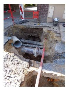
Les travaux effectués consistent au remplacement des canalisations actuelles d'un diamètre de 20 à 25 cm devenant insuffisantes par temps de pluie, par des canalisations de diamètres supérieurs, de 30 à 40 cm permettant d'assurer l'évacuation complète des effluents.
