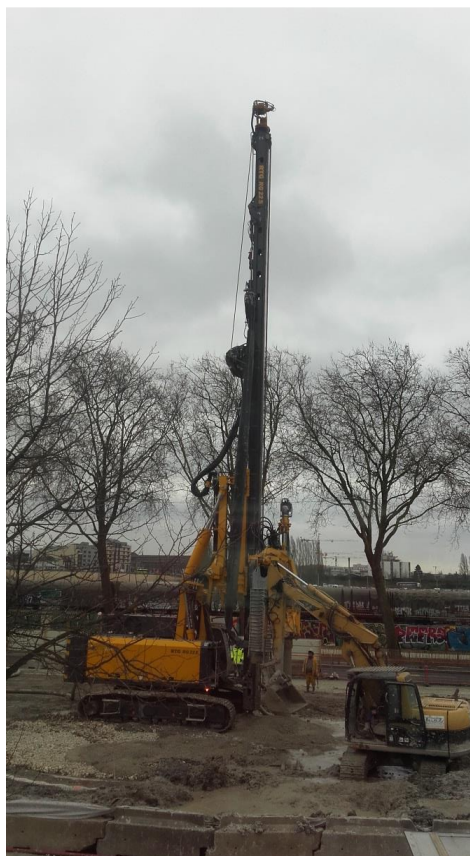
Foreuse pour la réalisation des puits de travail
