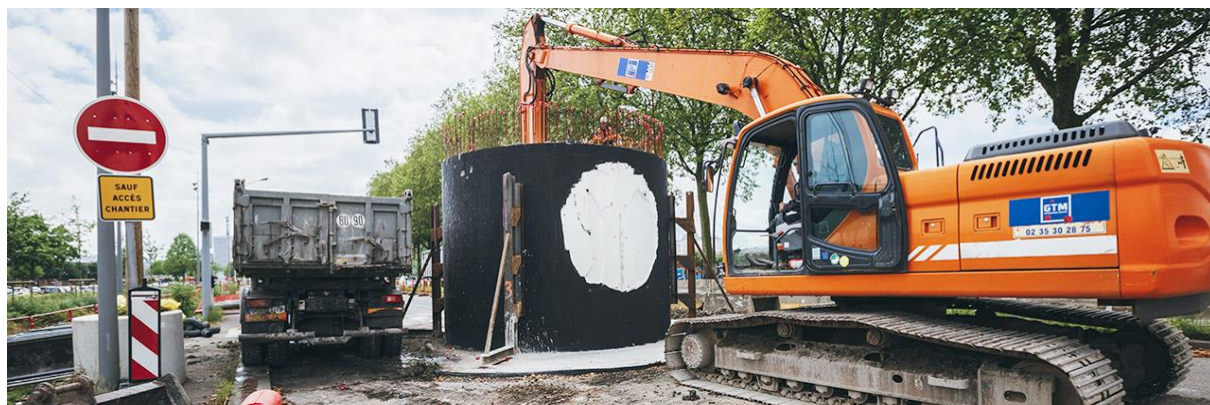
Réalisation de puit par havage
