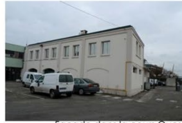
Façade dans la cours Ouest
