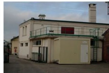
Façade arrière Est
