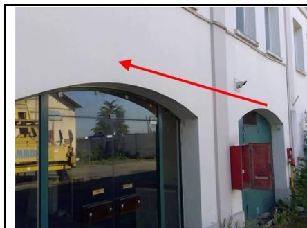
Photo n° PhA083 Localisation : Parties extérieures Ouvrage : Revêtement extérieur Partie d'ouvrage : Enduits Description : Enduits Localisation sur croquis : P088
