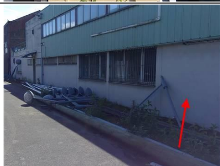
Photo n° PhA086 Localisation : Parties extérieures Ouvrage : Murs Partie d'ouvrage : Enduits + peinture Description : Enduits + peinture Localisation sur croquis : P096
