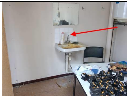
Photo n° PhA013 Localisation : Batiment C2 RDC - Réserve Ouvrage : Revêtements de murs Partie d'ouvrage : Colle faïence Description : Colle faïence Localisation sur croquis : P014
