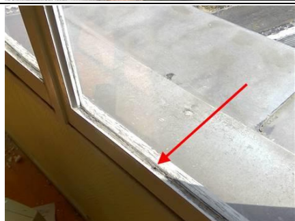
Photo n° PhA061 Localisation : Bâtiment C1 1er étage - Bureau 8 Ouvrage : Fenêtres Partie d'ouvrage : joint vitrage Description : joint vitrage Localisation sur croquis : P064
