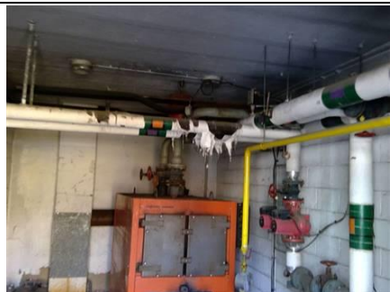
Photo n° PhA059 Localisation : Bâtiment C2 RDC - Chaufferie Ouvrage : Flocages, Calorifugeages, Faux plafonds Partie d'ouvrage : Calorifugeages Description : Calorifugeages Localisation sur croquis : P061
