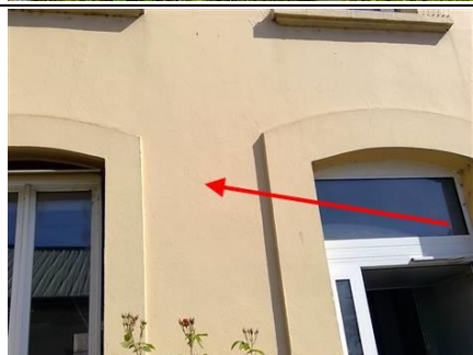
Photo n° PhA085 Localisation : Parties extérieures Ouvrage : Murs Partie d'ouvrage : Enduit + peinture Description : Enduit + peinture Localisation sur croquis : P095
