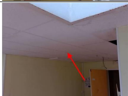
Photo n° PhA062 Localisation : Bâtiment C1 1er étage - Bureau 8 Ouvrage : Flocages, Calorifugeages, Faux plafonds Partie d'ouvrage : Faux plafonds Description : Faux plafonds Localisation sur croquis : P065
