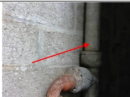
Photo n° PhA060 Localisation : Bâtiment C1 1er étage - Dégagement Ouvrage : Conduits de fluides (air, eaux, autres fluides) Partie d'ouvrage : Conduits fibres-ciment Description : Conduits fibres-ciment Localisation sur croquis : P062
