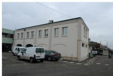
Façade dans la cours Ouest
