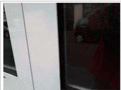
Prélèvement - P023 : Extérieur / Façade sur rue - Joint- (Absence d'amiante)
