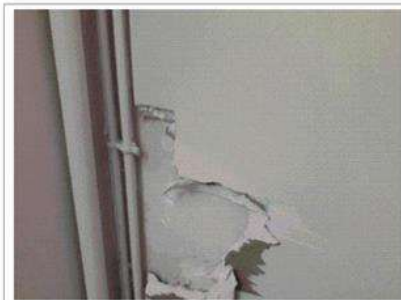
Prélèvement - P018 : Rez-de-chaussée / Pièce 2 - Panneau de cloison- (Absence d'amiante)
