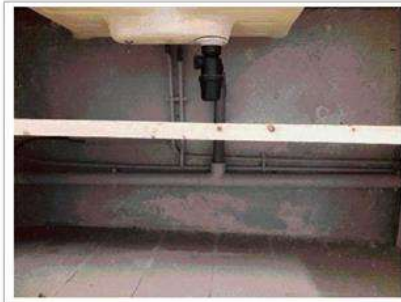
Déclaré - : Rez-de-chaussée / Cuisine - Conduit- (Absence d'amiante)
