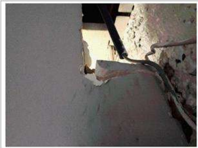
Prélèvement - P015 : Rez-de-chaussée / Pièce 1 - Plaque- (Absence d'amiante)
