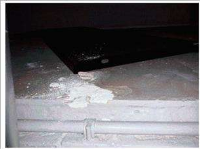
Prélèvement - P019 : Rez-de-chaussée / WC - Plaque- (Absence d'amiante)
