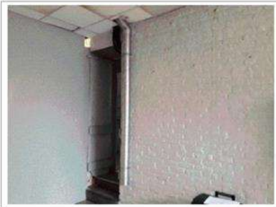
Déclaré - ; Rez-de-chaussée / Pièce 1 - Conduit- (Absence d'amiante)
