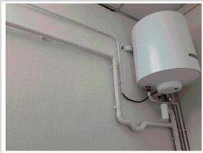
Déclaré - : Rez-de-chaussée / Pièce 2 - Conduit- (Absence d'amiante)
