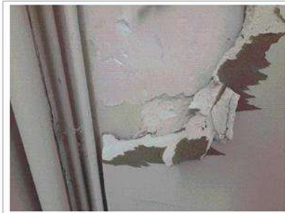
Prélèvement - P016 : Rez-de-chaussée / Pièce 2 - Plot de colle - (Absence d'amiante)
