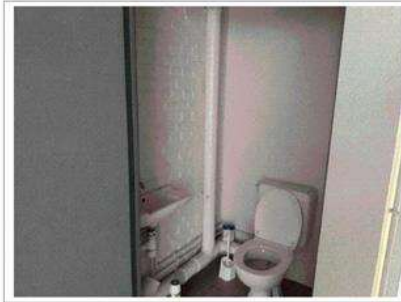
Déclaré - : Rez-de-chaussée / WC - Conduit- (Absence d'amiante)
