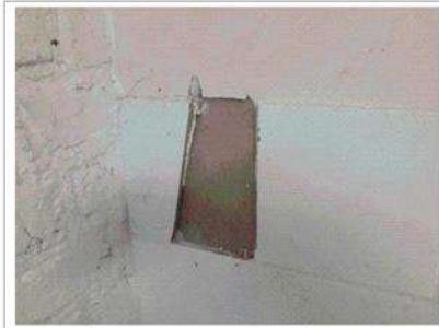
Prélèvement - P014 : Rez-de-chaussée / Cuisine - Colle de faïence- (Absence d'amiante)
