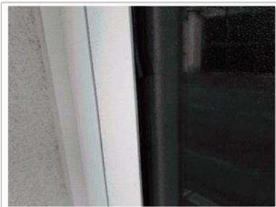
Prélèvement - P022 : Extérieur / Façade sur rue - Joint- (Absence d'amiante)
