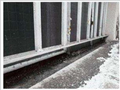
Prélèvement - P027 : Extérieur / Façade sur rue - Joint- (Absence d'amiante)
