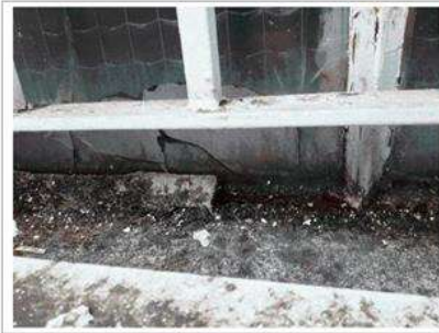
Prélèvement - P026 : Extérieur / Façade sur rue - Joint- (Absence d'amiante)
