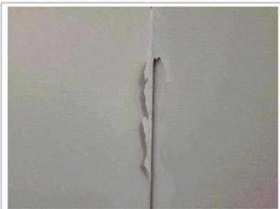
Prélèvement - P011 : Rez-de-chaussée / Cuisine - Peinture- (Absence d'amiante)
