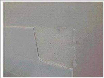
Prélèvement - P013 : Rez-de-chaussée / Cuisine - Colle de faïence- (Absence d'amiante)
