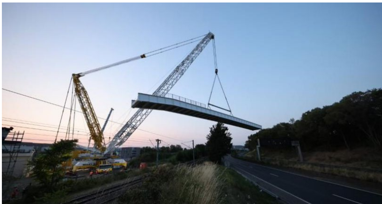
Opération de grutage du tablier de la passerelle qui relie le quartier de la Piscine au centre-ville du Petit Quevilly au-dessus la Sud 3 et la voie de chemin de fer
