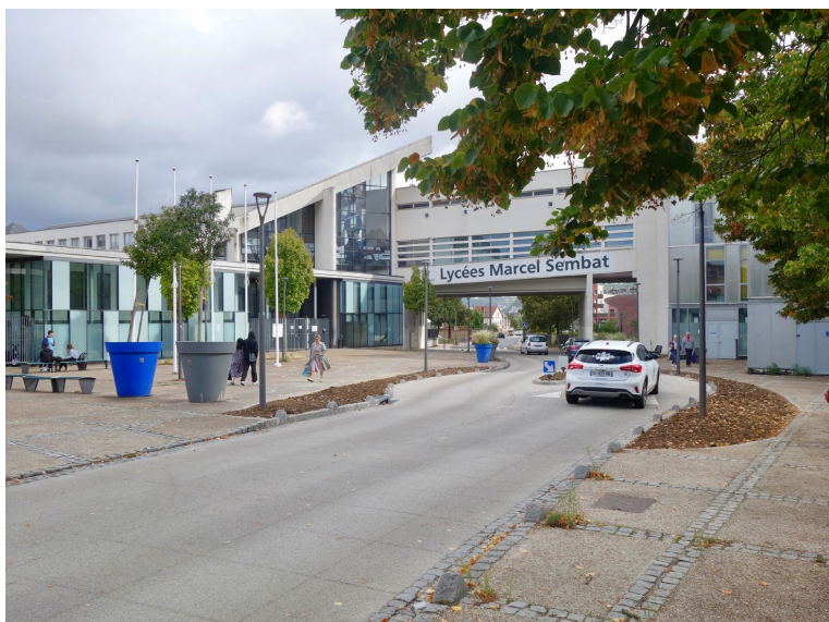
Rénovation du revêtement et création d'une zone de rencontre rue Léon Salva à Sotteville Lès Rouen
