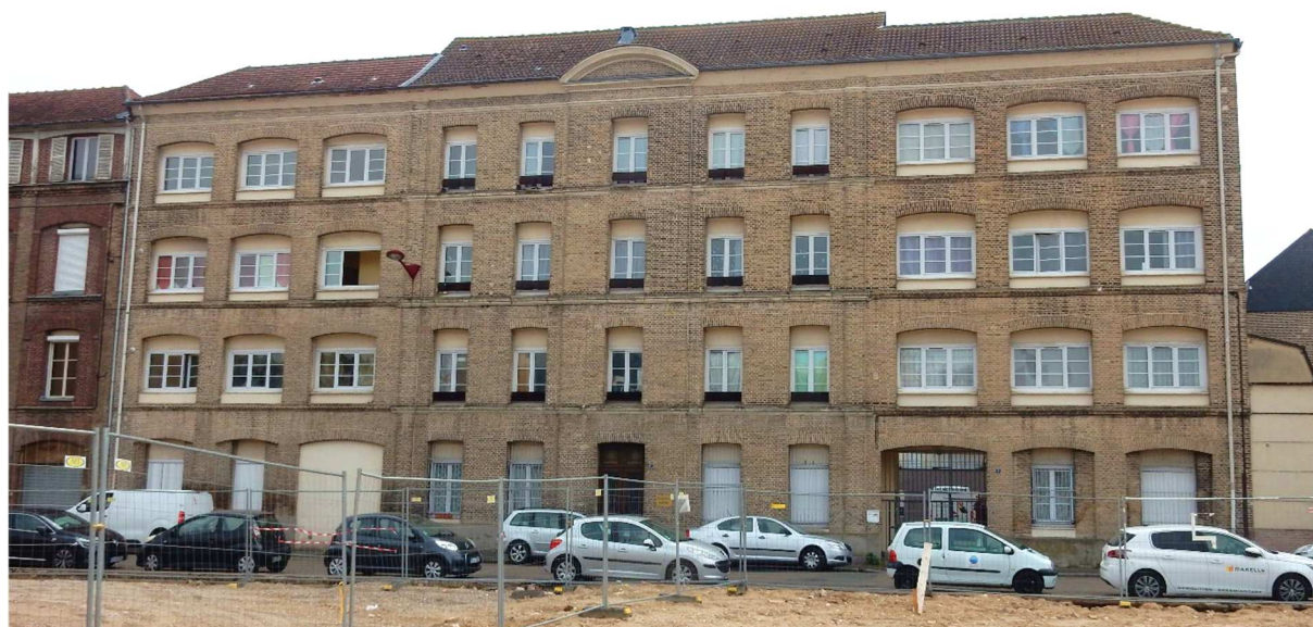
Ancienne usine textile transformée en immeuble d'habitations située rue Cousin Corblin, face au périmètre de projet
