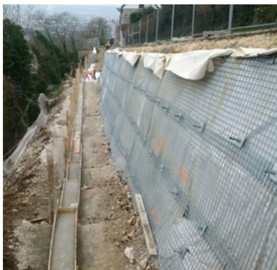
Après les travaux
