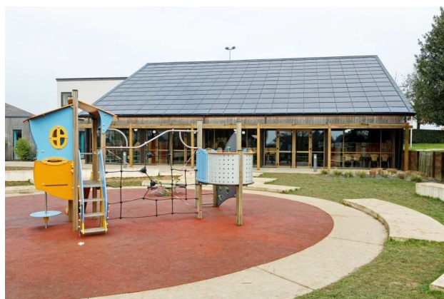
La nouvelle toiture de l'école maternelle « Oiseau de feu »
