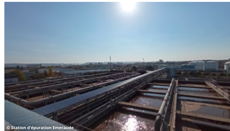
© Station d'épuration Émeraude
