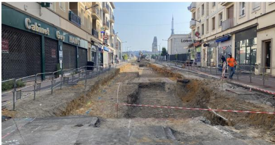
Évacuation des remblais de la reconstruction le long de la voie circulée – Crédit : Métropole Rouen Normandie
