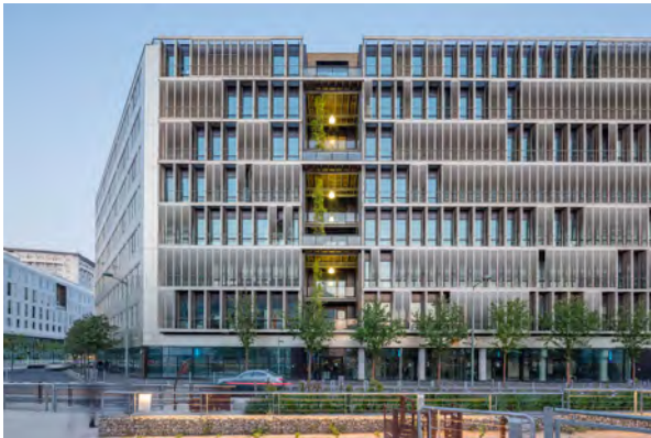
Référence: Immeuble double peaux avec façades modulables, loggia double hauteur et dispositifs de protection solaire. Localisation :Arceuil (94) Architecte: François Lerclercq
