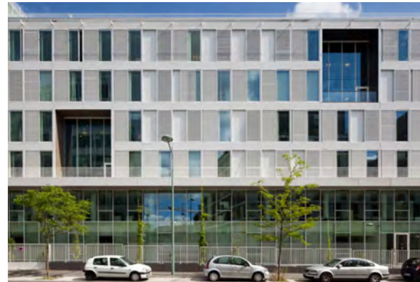
Référence: Immeuble double peaux avec façades modulables , loggia double hauteur et dispositifs de protection solaire. Localisation :Arceuil (94) Architecte: François Lerclercq
