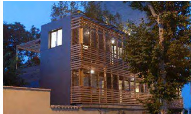
Référence: Immeuble double peaux avec façades modulables , loggia double hauteur et dispositifs de protection solaire. Localisation :Arceuil (94) Architecte: François Lerclercq
