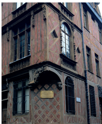
Bâtiment du 19 e siècle en pan-de-bois
