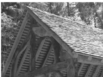
Les bardeaux de la toiture côté route sont en châtaignier
