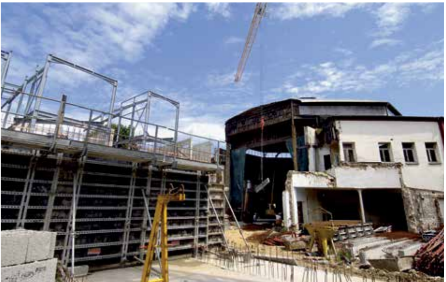
Construction des annexes, 2005
